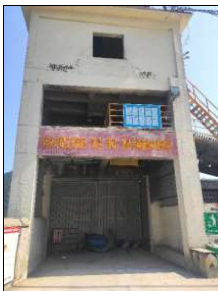
转运间（卷扬机房）
