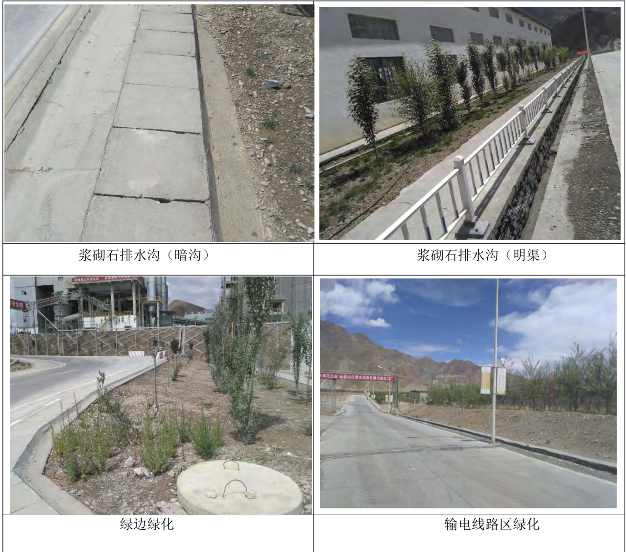
图 6-5 附属工程区监测照片
